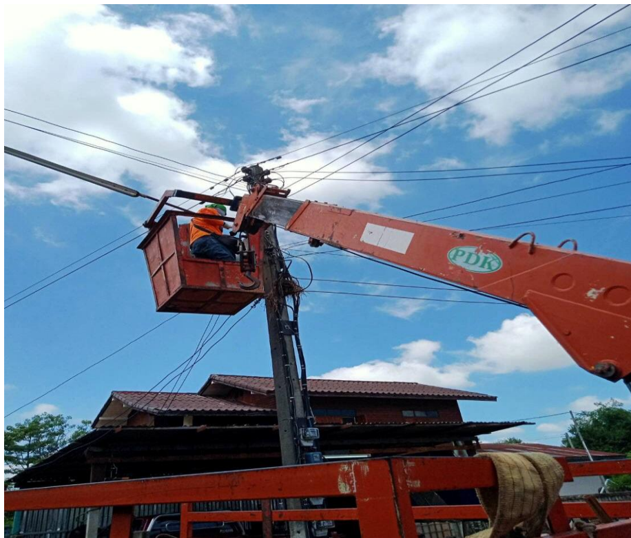
รูปภาพที่ 4.8 ตัวอย่างการให้บริการประชาชนในพื้นที่ อาทิ การติดตั้ง ซ่อมแซม ไฟฟ้าส่องสว่างในชุมชนตำบลหนองสิม
