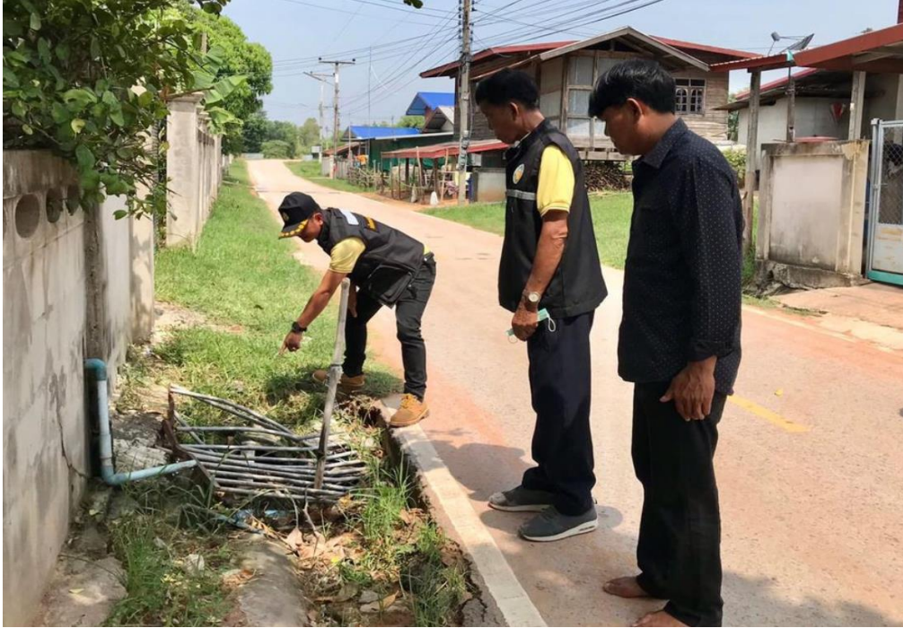
รูปภาพที่ 4.3 ตัวอย่างการให้บริการประชาชนในพื้นที่ อาทิ การลงพื้นที่ปรับปรุงซ่อมแซมร่องระบายน้ำในชุมชนตำบลหนองสิม
